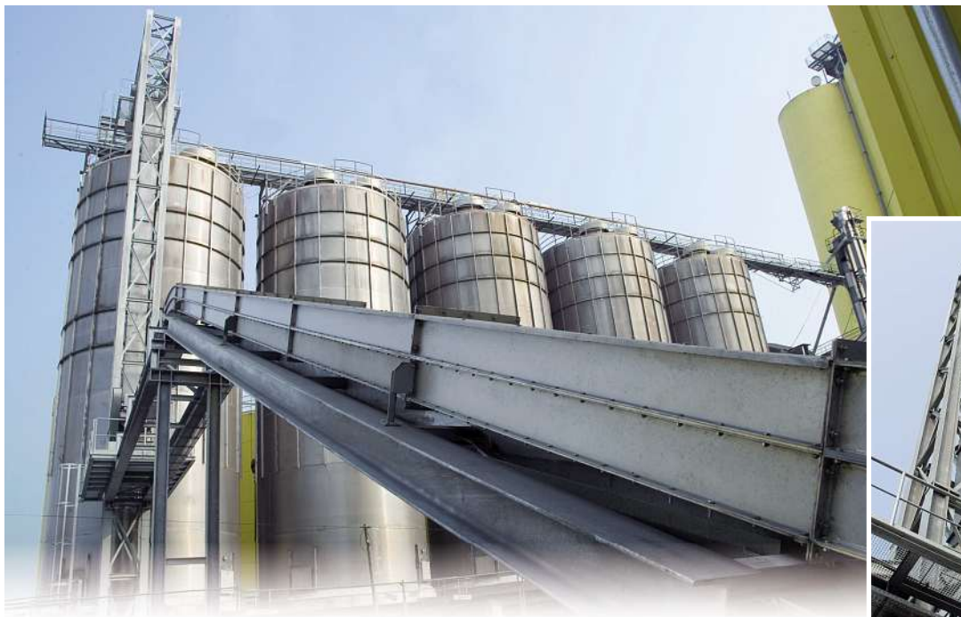
◀ ▼ Trogkettenförderer (TKF) zur Beschickung von Silos mit geneigter, horizontaler und vertikaler Förderstrecke
