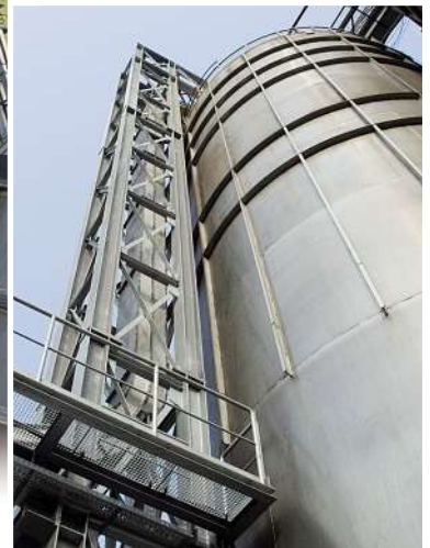
◀ ▼ Trogkettenförderer (TKF) zur Beschickung von Silos mit geneigter, horizontaler und vertikaler Förderstrecke
